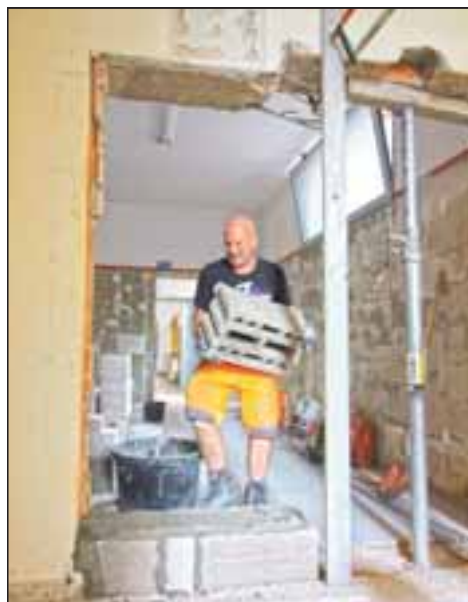
Für neue sanitäre Anlagen muss im Untergeschoss eine Tür versetzt werden.
