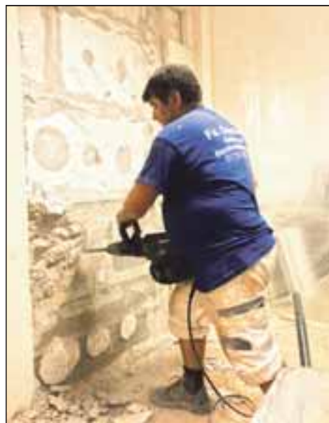
Ein Arbeiter bricht mit schwerem Gerät durch eine Wand, um einen Fluchtweg zu schaffen.
